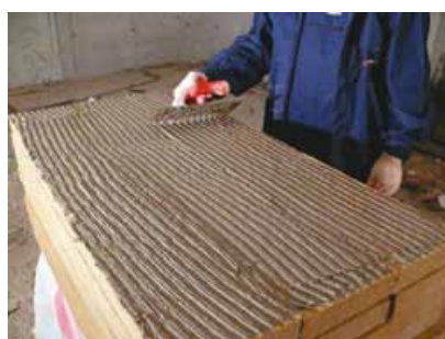
Rozprowadzanie zaprawy packą zębatą
