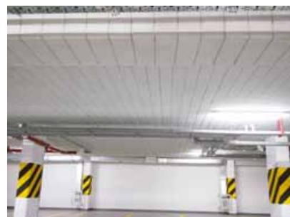
Pomalowana powierzchnia sufitu
