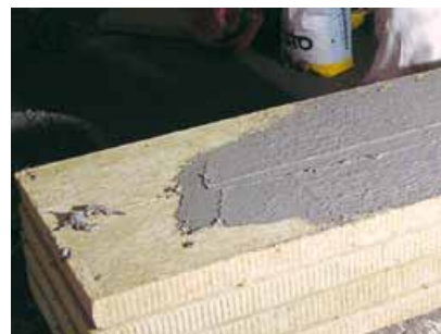
Pokrywanie zaprawą klejową tylnej powierzchni płyty PAROC CGL 20cy
