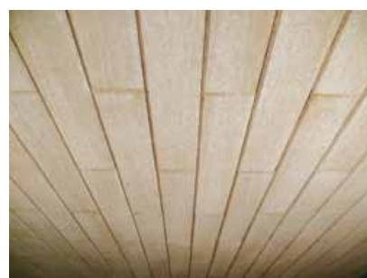
Wygląd gotowego sufitu
